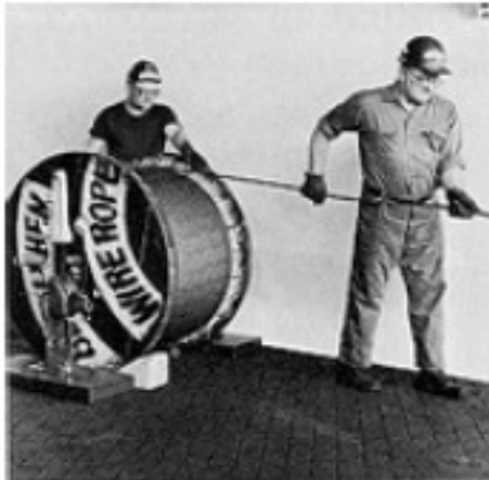
Figura N°6. Manera correcta de desenrollar/devanar un conductor en carrete.
