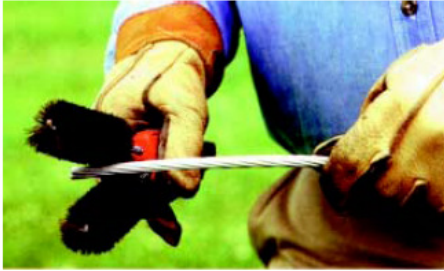
Figura N°2, Limpieza del Conductor
