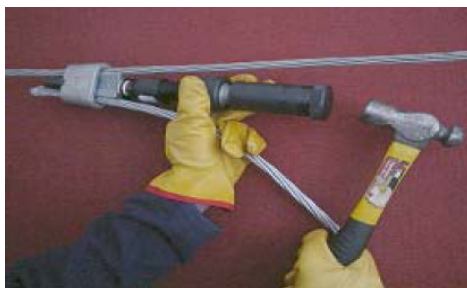
Figura N°8, Instalación de la Cuña
