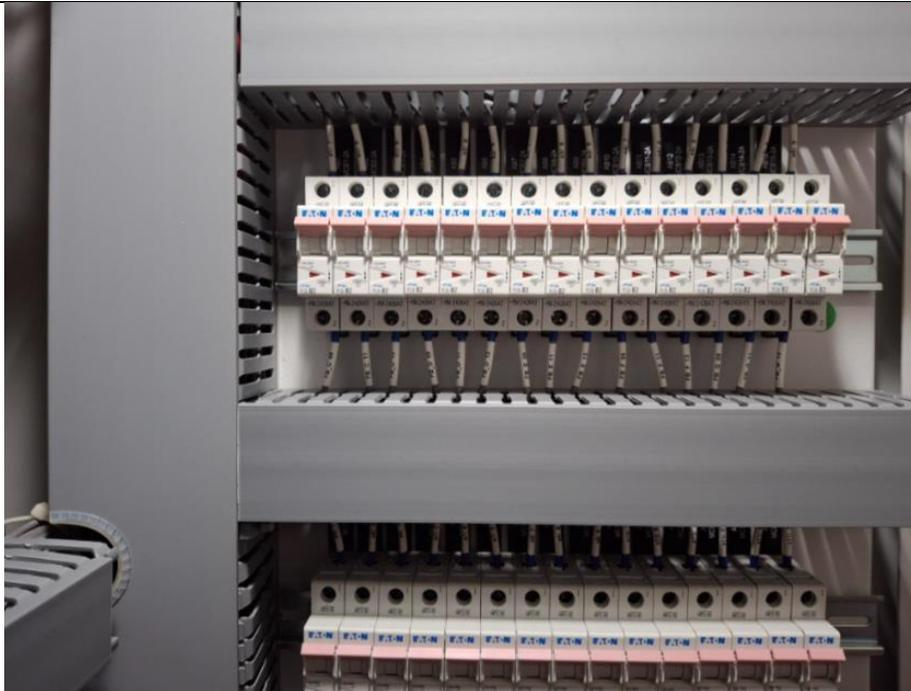
**Figura 11. Arreglo sugerido para los breakers de alimentación.**
