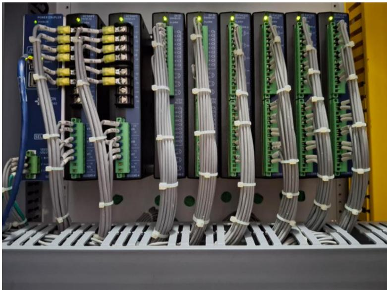
**Figura 15. Referencia de cableado para el SEL-AXION.**
