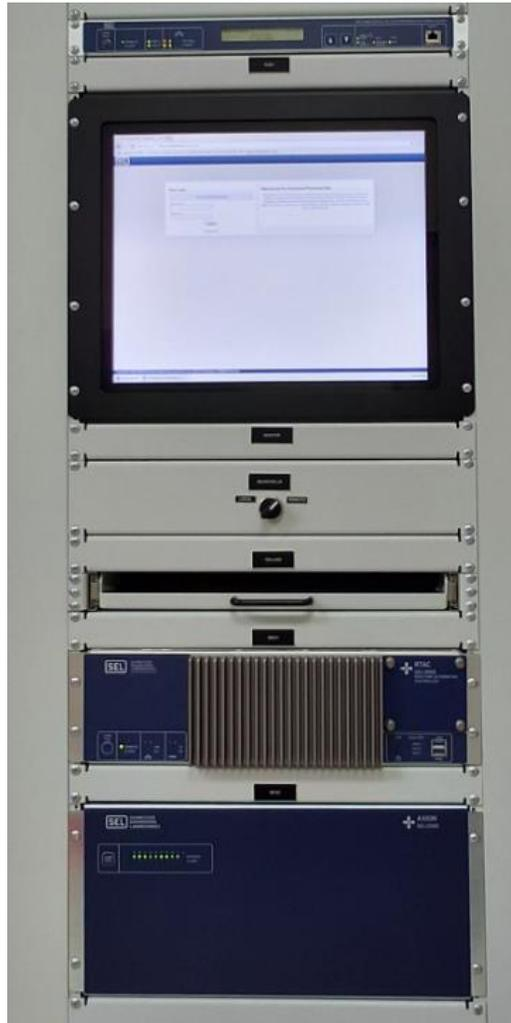
**Figura 13. Distribución para la pantalla HMI y teclado de la RTU.**
