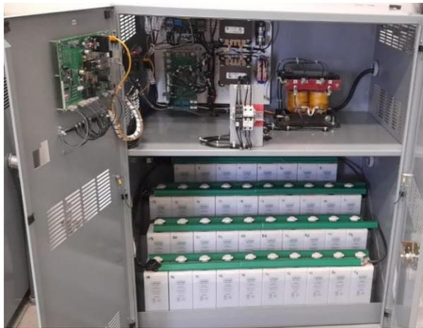
**Figura 25. Referencia del gabinete para cada banco de baterías y su cargador.**
