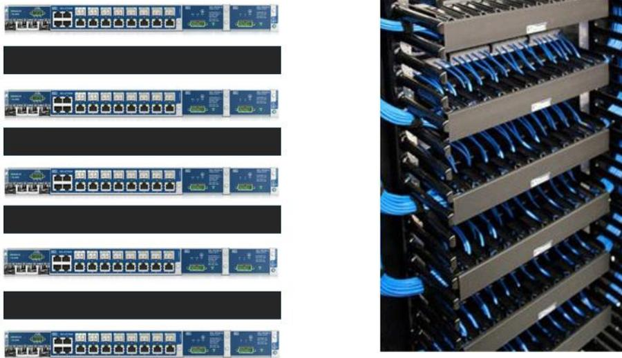
**Figura 18 - Espaciamento sugerido para los organizadores de cableado.**
