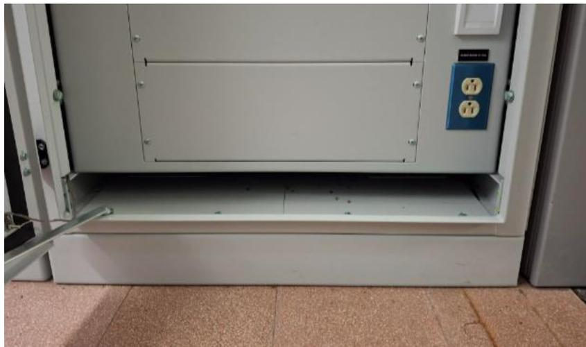
**Figura 12. Ejemplo de tomacorriente de 120Vac para mantenimiento.**
