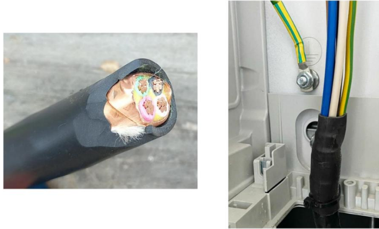
Figura 4.4.3 - Cable multi conductor con aterrizaje.
