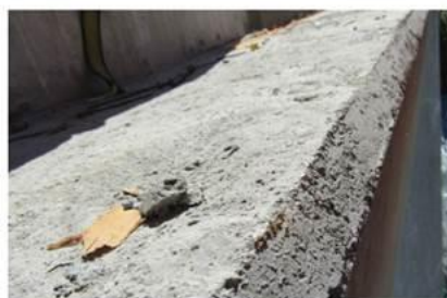
Imagen 3. Los bordes de concreto pueden cortar las líneas de vida y las cuerdas de seguridad.
