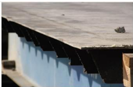
Imagen 2. Los bordes metálicos pueden cortar las líneas de vida y las cuerdas de seguridad.
