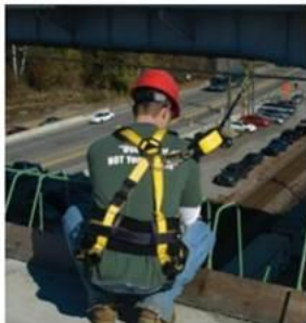
Imagen 1. Una línea de vida horizontal podría evitar que las cuerdas de seguridad entren en contacto con los bordes expuestos.
