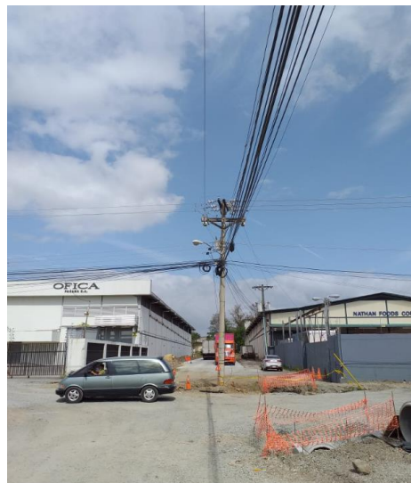
Figura 2: Antiguo poste en medio de la nueva calle.
