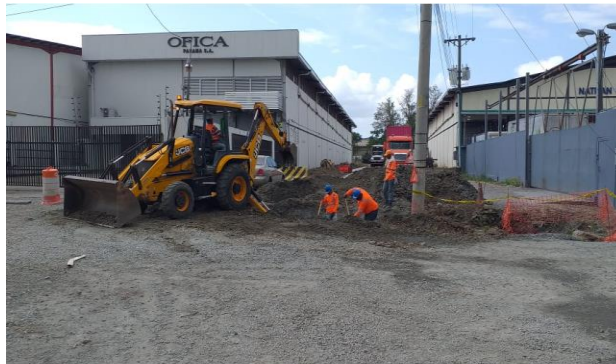
Figura 1: Construcción de nueva calle en el área de Llano Bonito.
