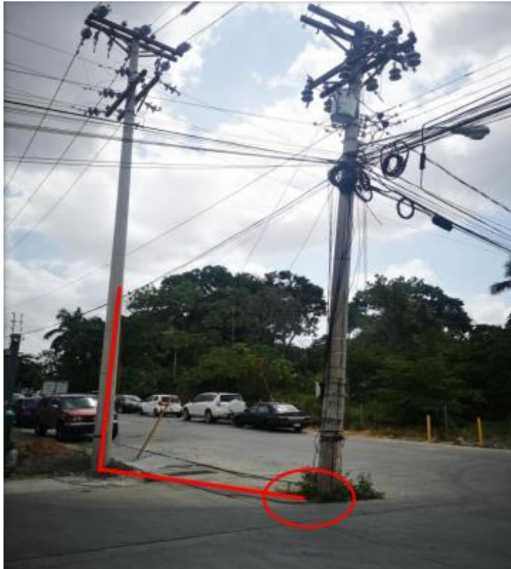
Figura 5 : Obra civil para pasar una fibra óptica al nuevo poste.
